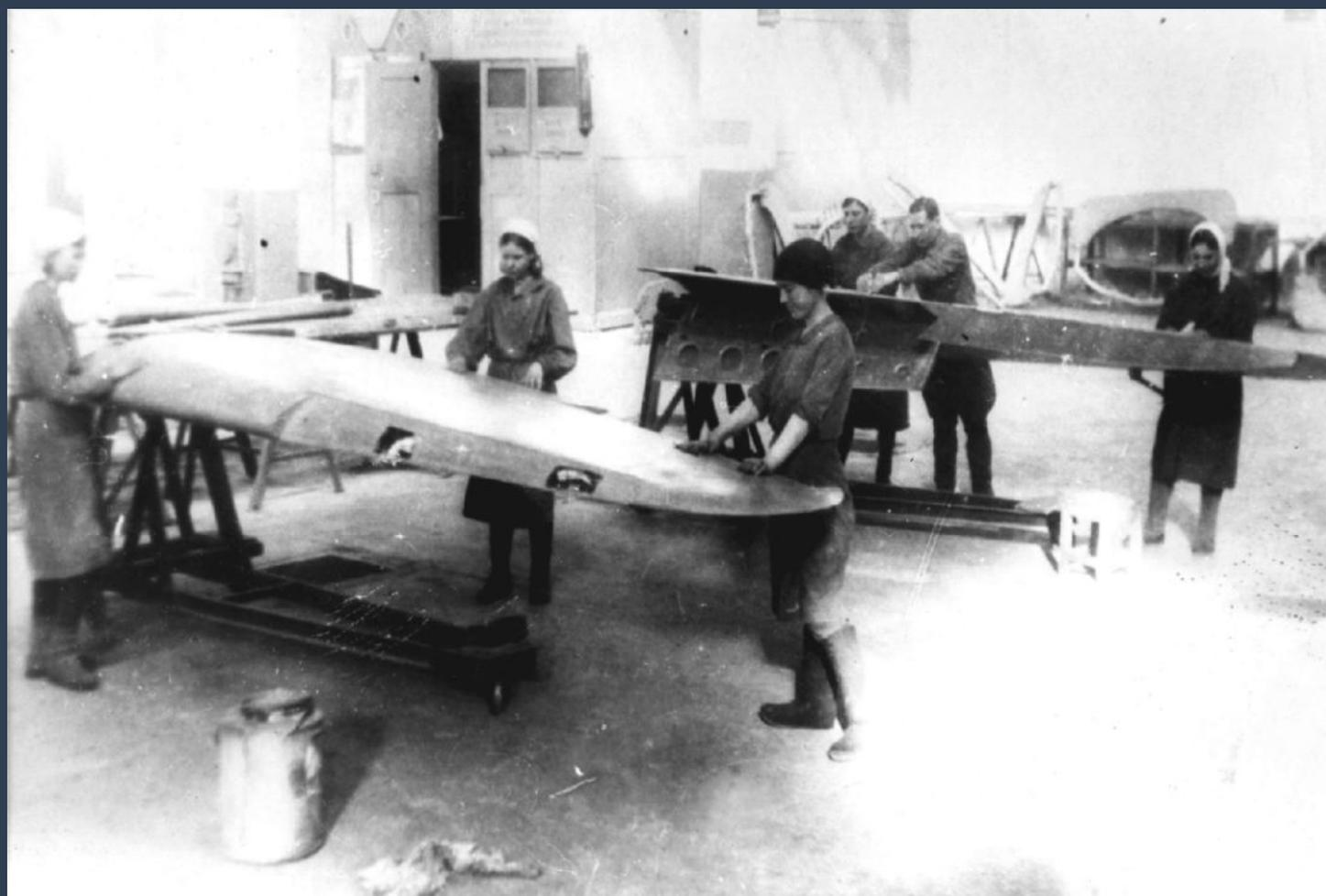
Сборка крыльев самолетов в цехе Авиационного завода г. Улан-Удэ
